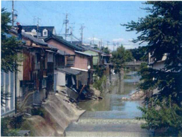
被害を出した伊賀川
