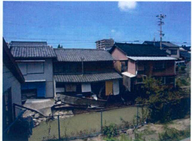
水が流れ込んだ川沿いの家屋
