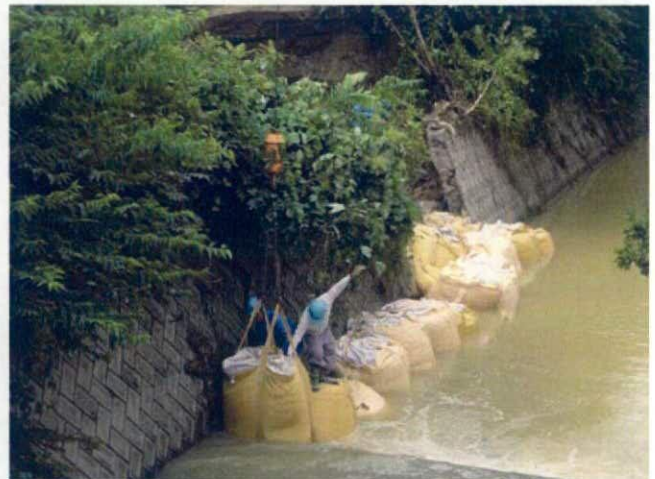
護岸の応急補修（栄町・大平町）
