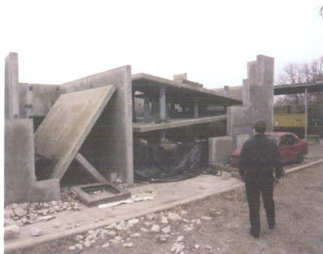
Shoring(支柱)作成訓練
