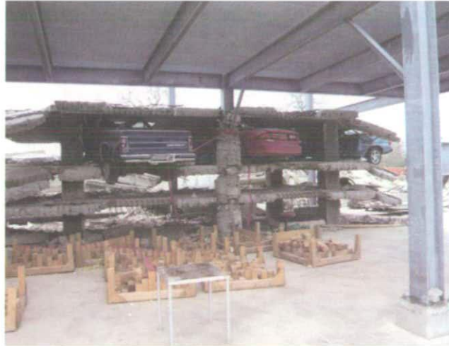
立体駐車場の圧壊
