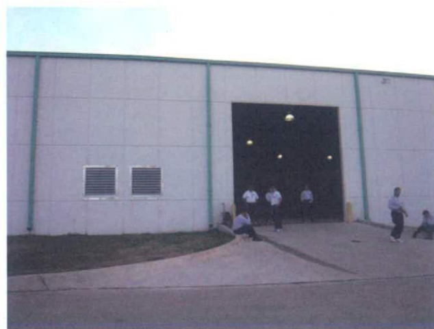
基地兼備蓄倉庫
