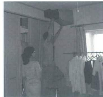
写真6 風量測定の様子
