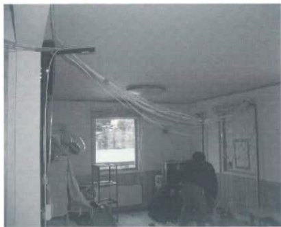
写真4 換気量測定の様子（室内）
