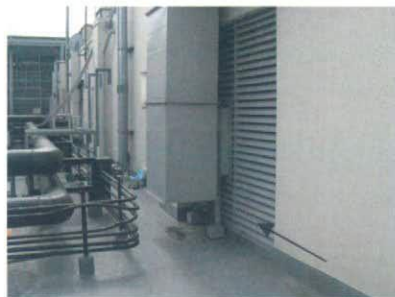
図1 屋上にある外気取り入れ口
