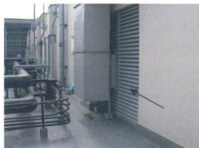
図1 屋上にある外気取り入れ口
