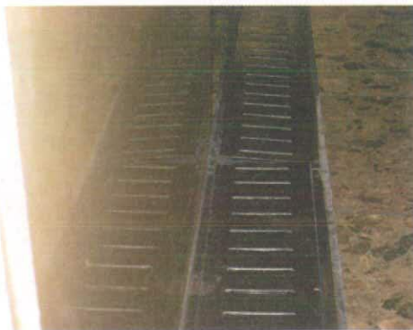
(写真13) 通路端の排水溝
