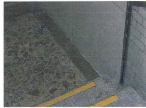
(写真12) 外階段排水溝
