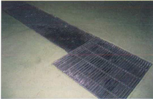
（写真3）塗り床と排水溝
