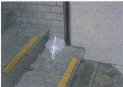
(写真11) 外階段のゴミ
