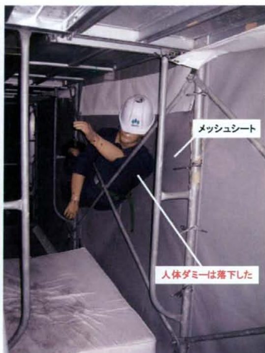
写真 21 実験⑥の実験後の状況
