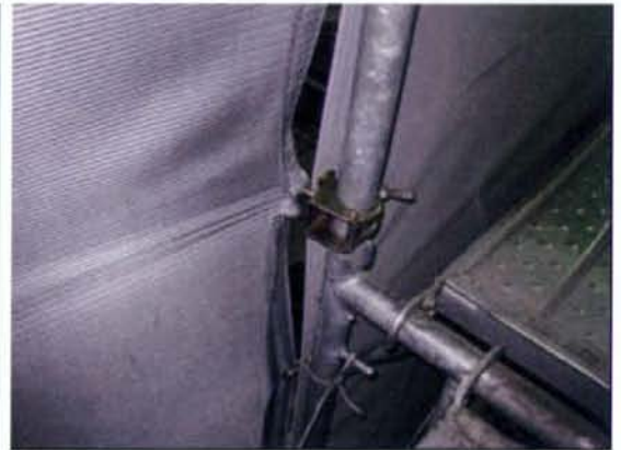
写真5 両サイドで金具により強力に固定した場合
