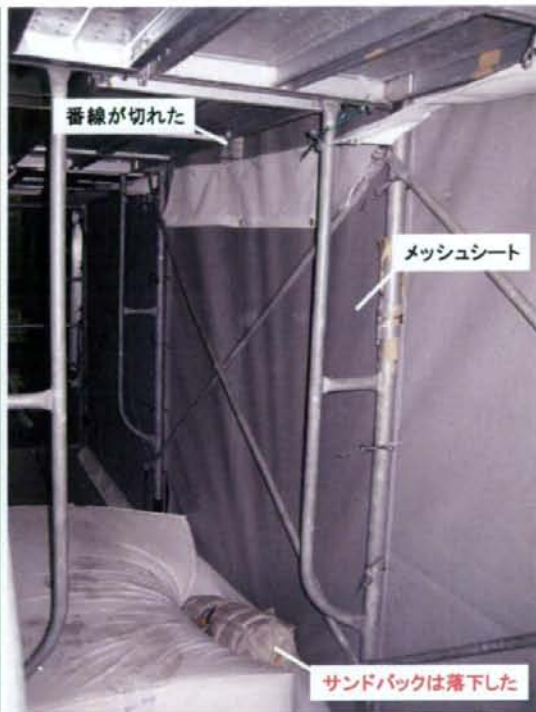
写真 13 実験②の実験後の状況
