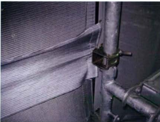
写真6 メッシュシートを2枚重ねにして伸びを抑えた場合（金具併用）
