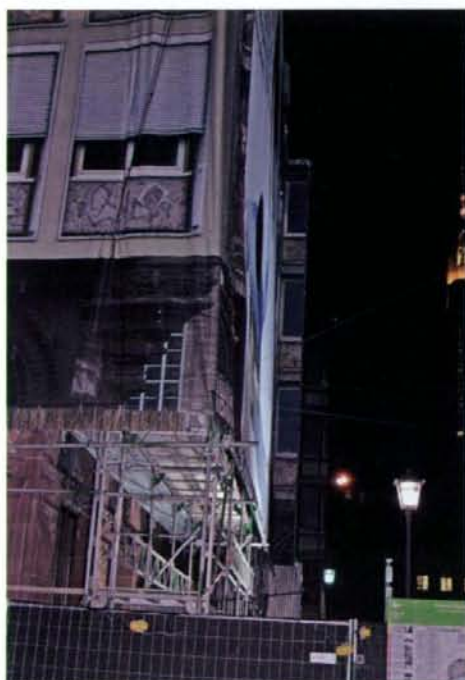
写真4 景観を配慮した足場用シートの状況
