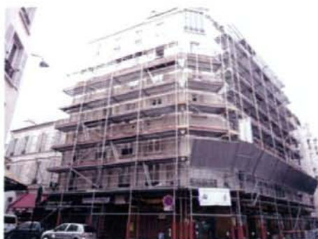
写真11 朝顔の設置状況
