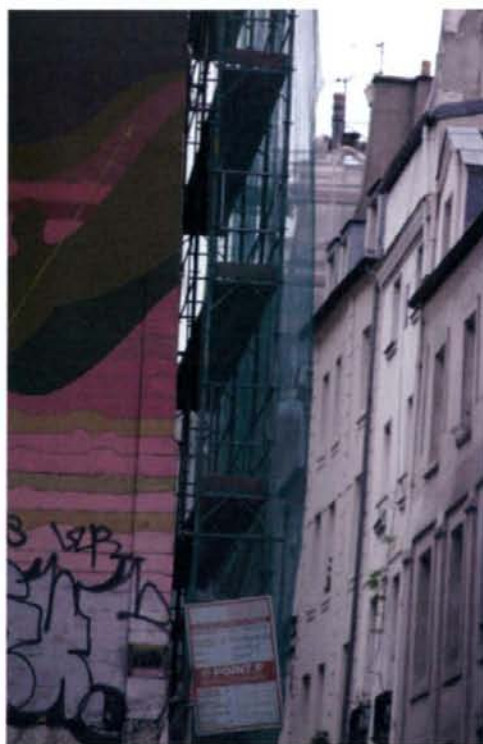
写真9 足場側面の手すりの設置状況 (同様に2段手すりとなっている)
