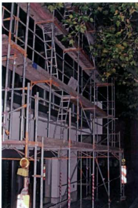
写真1 ドイツにおける足場の設置状況
