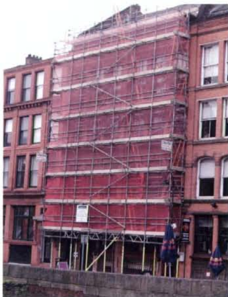
写真 12 イギリスにおける足場の設置状況
