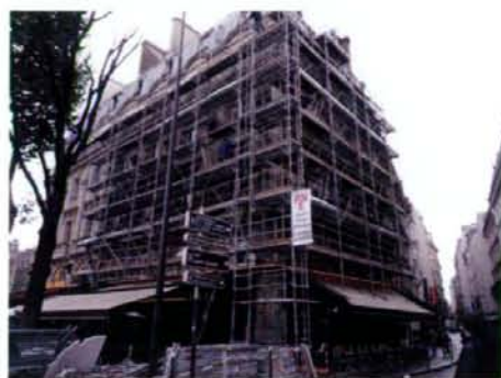
写真7 フランスにおける足場の設置状況
