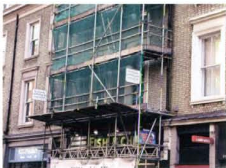
写真 17 落下物防護用の Fan の設置状況
