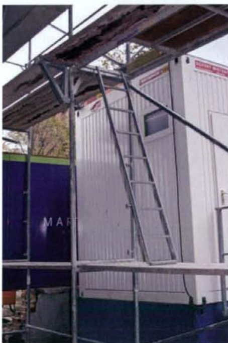
写真2 足場用階段の様子
