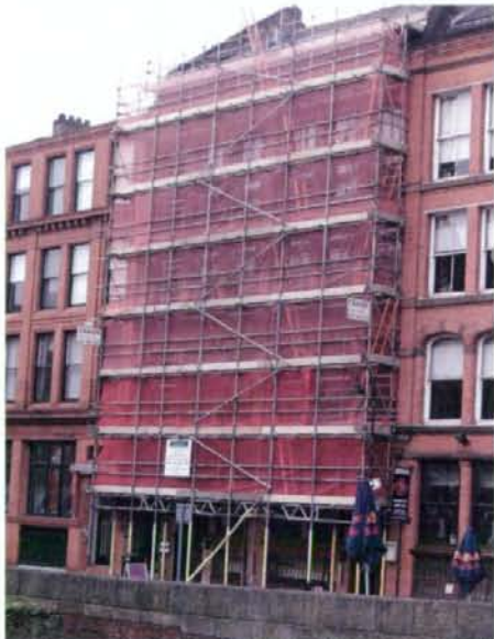
写真1 2段手すりと幅木の設置された足場
