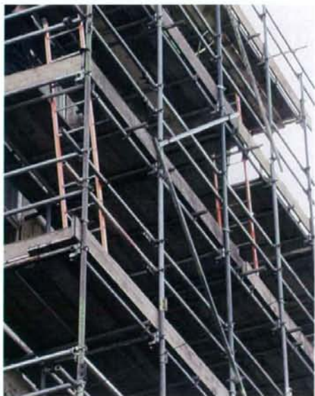
写真 14 階段周りの開口部
