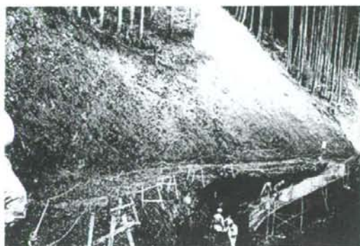
写真-1 斜面下での擁壁工の施工状況
