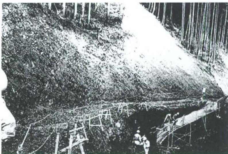
写真-1.1 切土斜面直下における擁壁工の施工状況の一例
