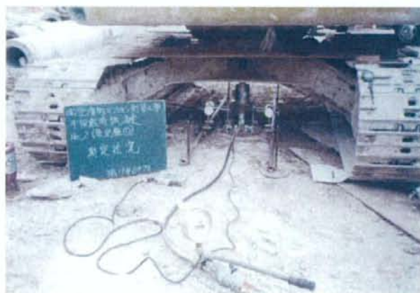
図 2-3-5 平板載荷試験の実施状況
