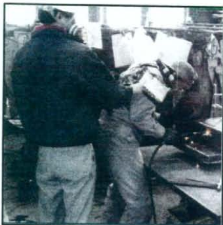
図 27 B 測定実施時の外観①
