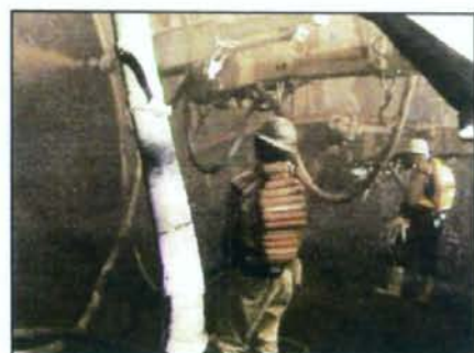
図 13 吹き付け作業の様子
