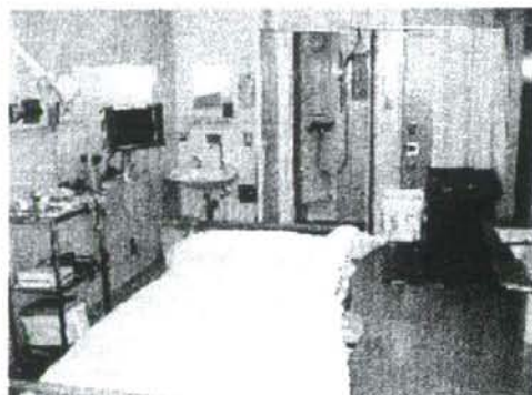
図4 国立国際医療センター戸山病院の新感染症病室 前室・陰圧室と独立した排気システムを持つ。
