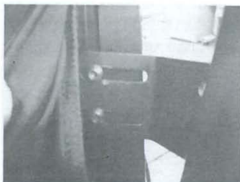
図2 側方支持部（固定部拡大）
