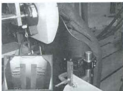
写真 13 上方基台が内側へ移動 (No1)
