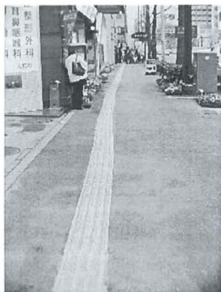
図14 分岐点がなく直線的に続く点字ブロック（くまもと安心移動ナビプロジェクト）
