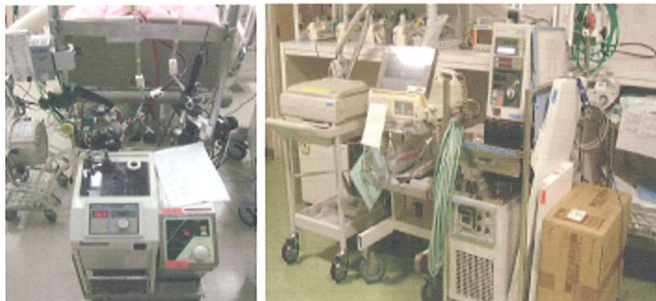
実際の冷温水槽使用例
