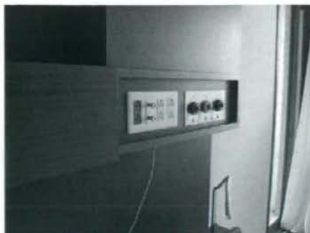
図.18 一般病棟病室 ガス吸入口
