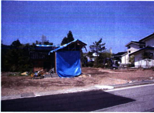
解体後更地となった様子
