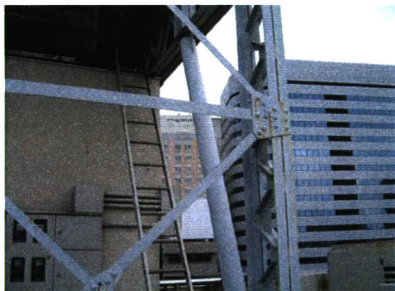
写真 5 梯子で昇降する高置水槽
