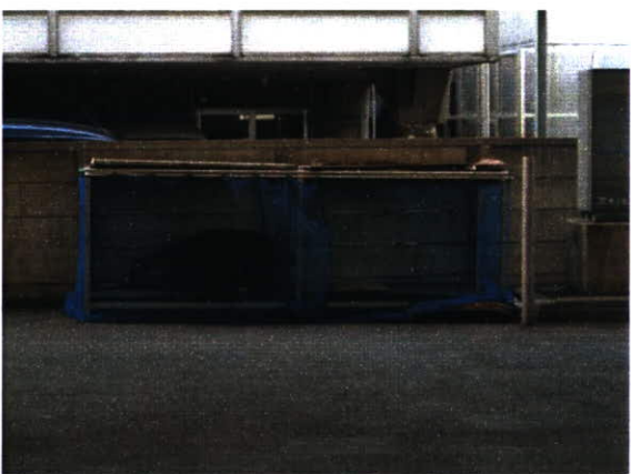
写真 15 区画が不十分な屋外型の廃棄物保管場所
