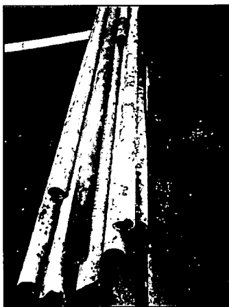
a) 掘り上げパイプ
