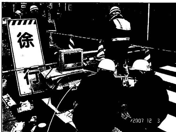
写真 4.6.26 カメラ調査前の調整
