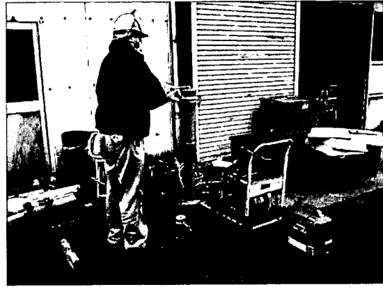
写真 4.6.13 水圧試験用ジグのセット
