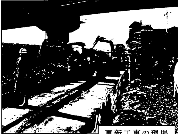
更新工事の現場
