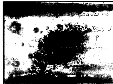
写真-6 TS継手内面接着剤の塗布状況(接着剤のはみ出し)
