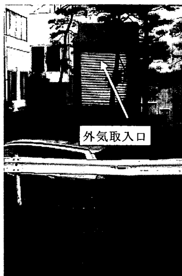
写真-1-1 空調の外気取入れ口不適切な設置例
