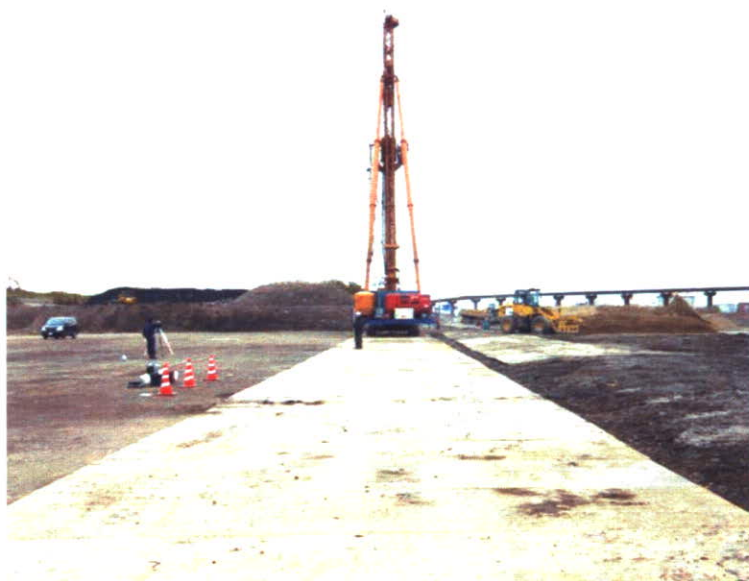
写真 3-5-2 敷鉄板が敷設された走行路の様子
