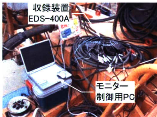
写真 3-5-5 上部旋回体に配置した計測装置
