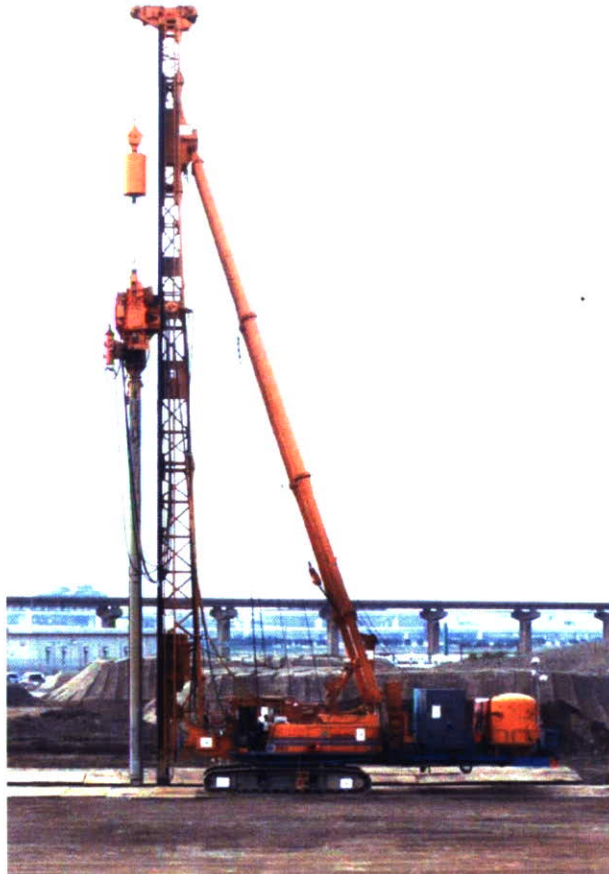
写真 3-5-1 自走実験に使用した杭打ち機械の外観
