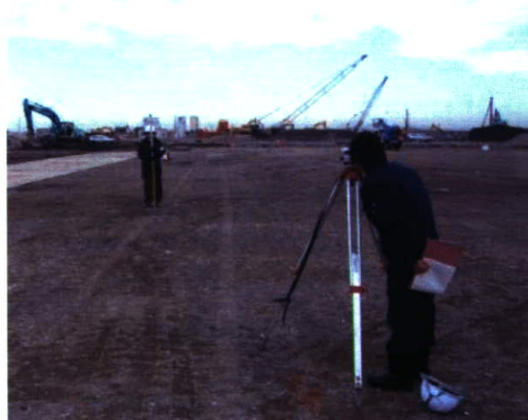
写真 3-3-1 水準測量の様子
