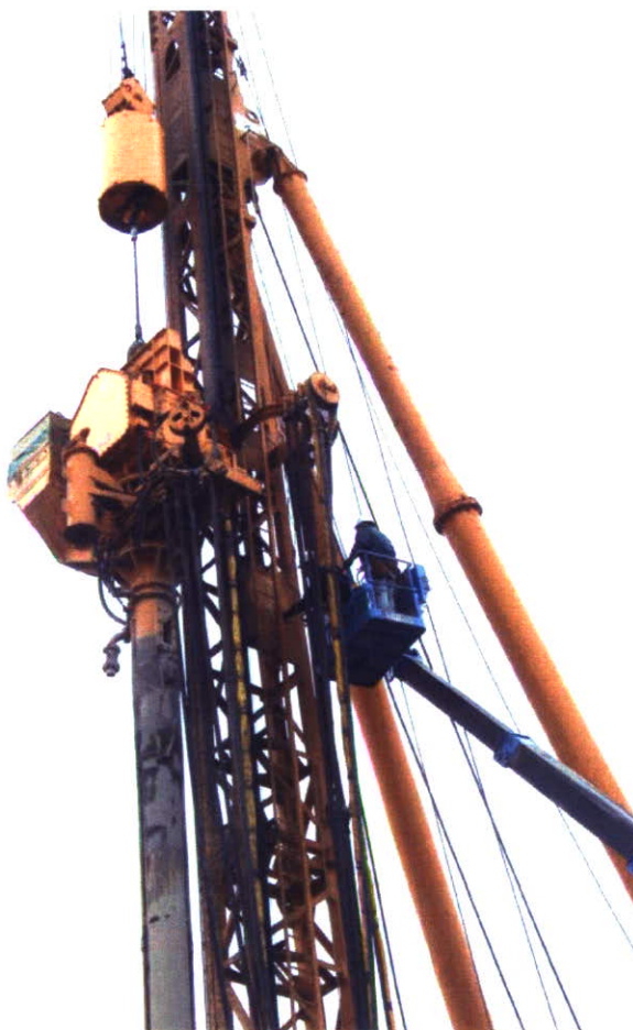
写真 3-5-4 高所作業車にて加速度計 Acc1 を設置する様子
