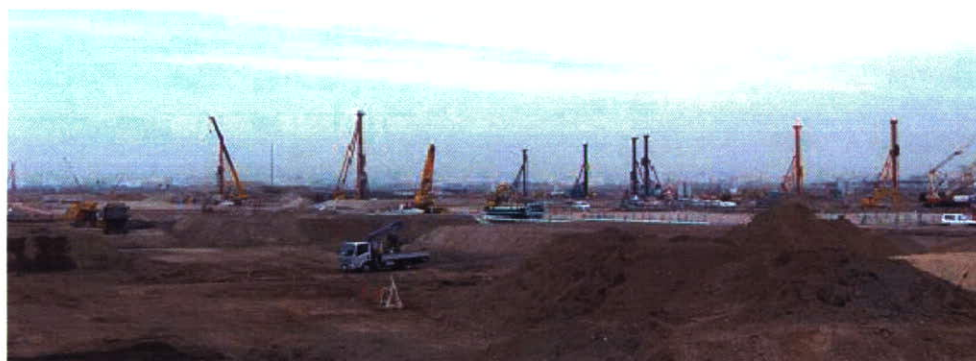
写真 3-1-1 東京国際空港国際線地区エプロン等整備事業の A 工区の様子
