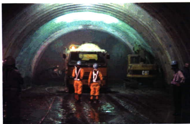
図 2 30 m地点に於ける粉じん濃度測定状況
