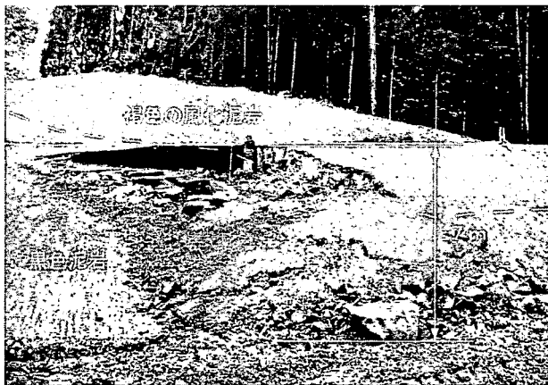
写真-2 船川層黒色泥岩の崩壊状況(秋田県中央部出羽丘陵) —表-1 のF地区—
