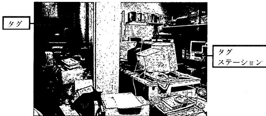
図 2 4. サーバ室内のタグとタグステーション
