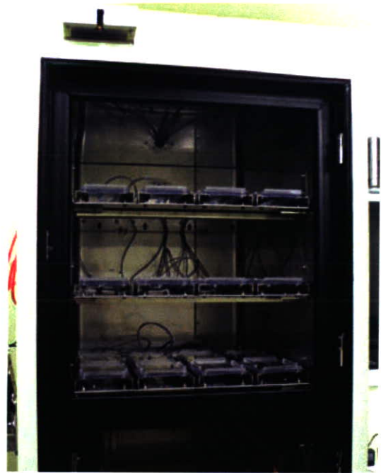
冷凍庫上部にトレイ棚を設置
