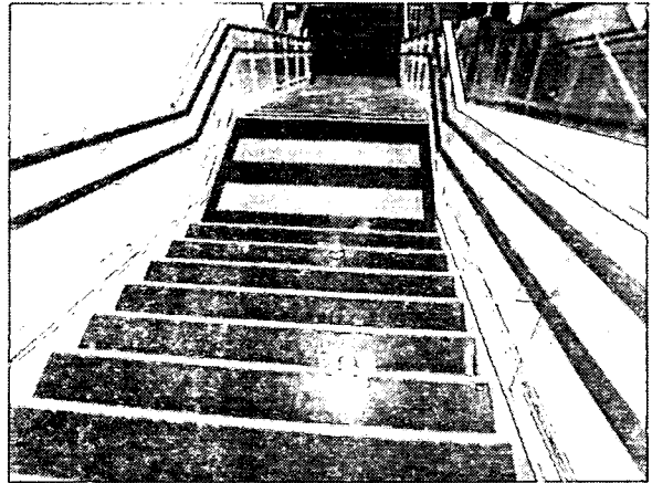
図10 黒いタイルに白い段鼻を施した階段
