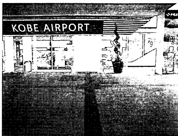
図21 コントラストの低い視覚障害者誘導用 ブロック
