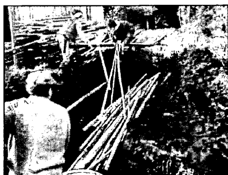
写真3: 里山の竹を用いた暗渠排水の構築 / 出所: 石井 (2008)
