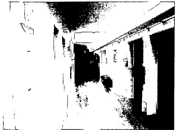
写真 廊下部分
