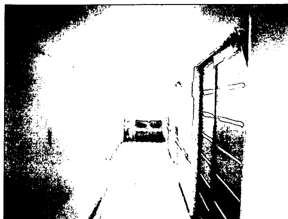
写真 廊下部分
