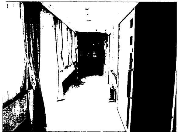
写真 廊下部分
