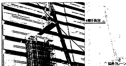
図8 クレーン搬入
