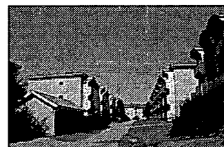
写真. 施設まわり。集合住宅構内に位置している
