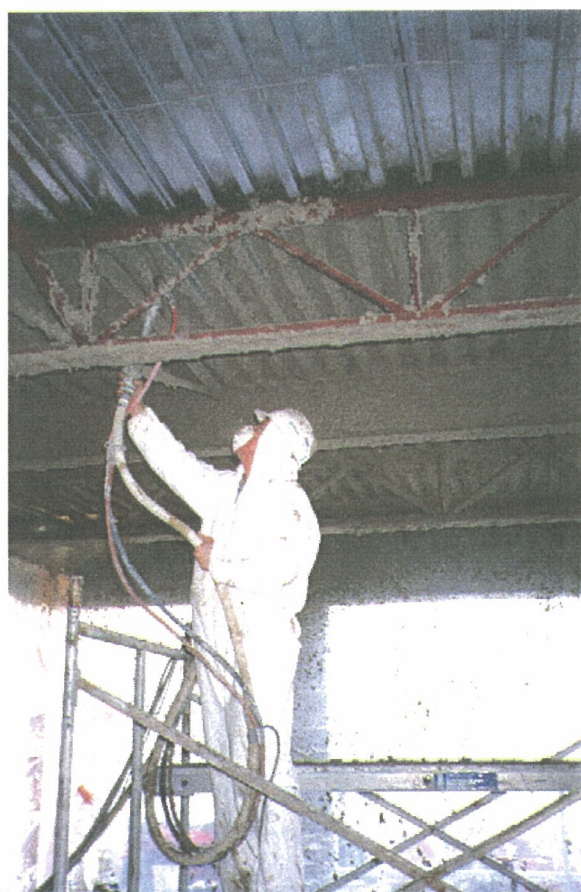
写真 2 プラスター吹き付け作業 7) ( http://en.wikipedia.org/wiki/Plaster より)
