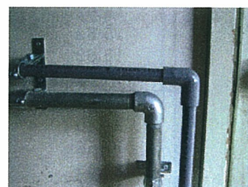
管の曲がり部(2)
