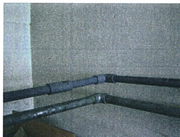
管の曲がり部(1)
