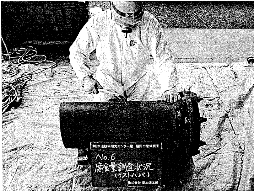
写真 手順-4 腐食量調査状況 (テストハンマ)
