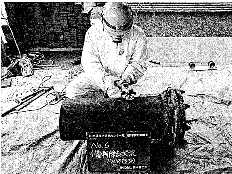
写真 手順-3 付着物除去状況 (ワイヤブラシ)
