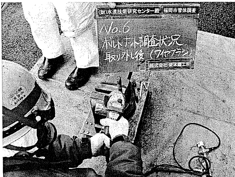
写真 手順-10 ボルト・ナット調査状況 ボルト取り外し後 (ワイヤブラシ)
