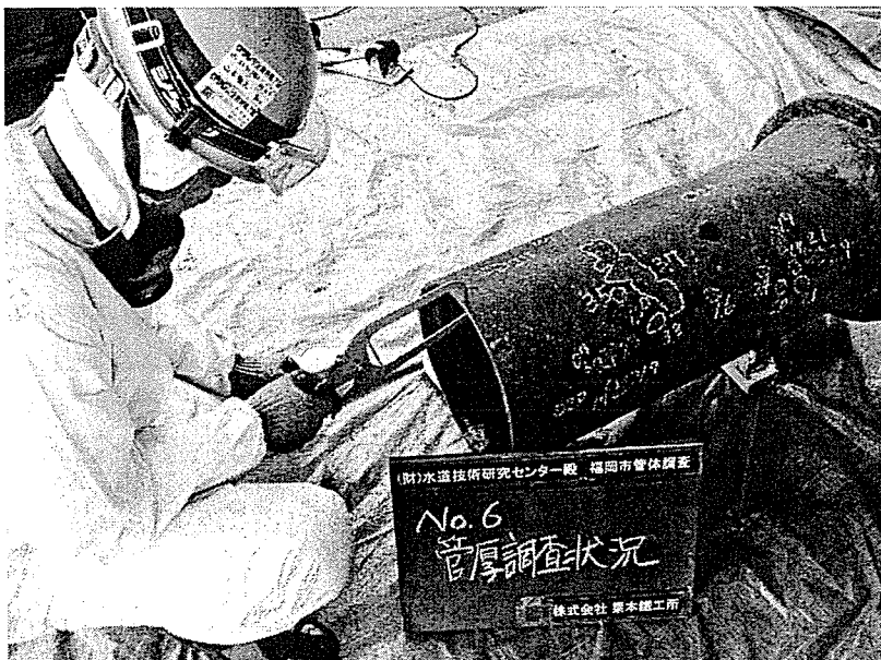
写真 手順-6 管厚調査状況
