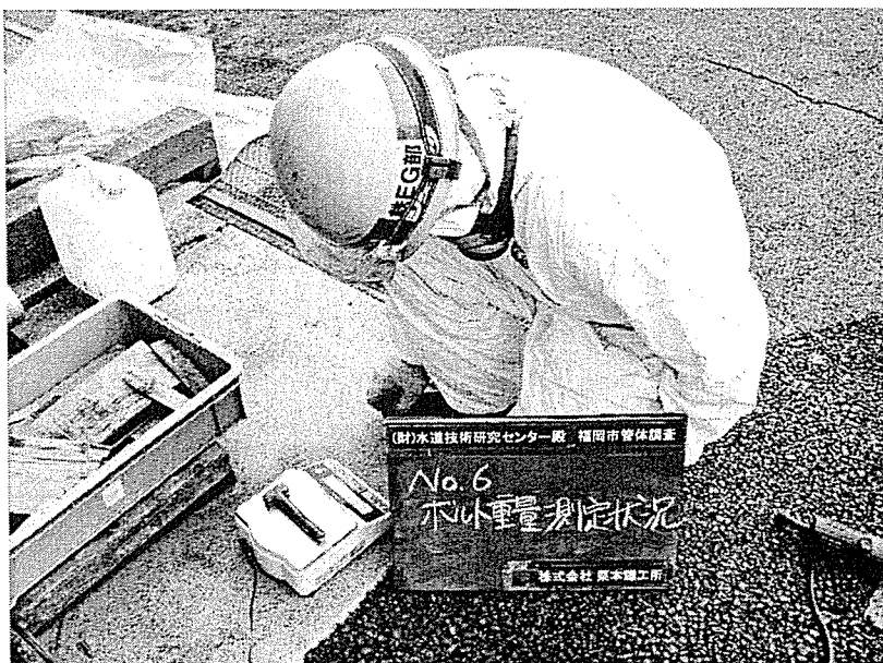
写真 手順-11 ボルト重量測定状況
