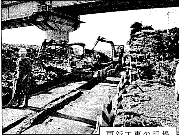
更新工事の現場
