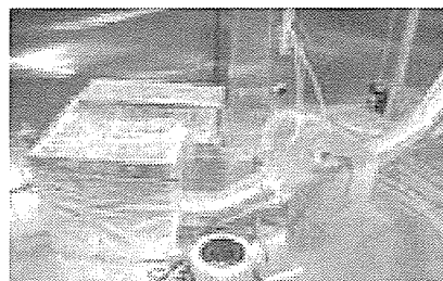
写真-1 循環型換気システムの空気清浄ユニット
