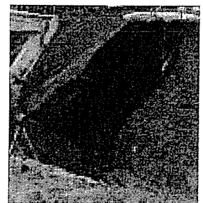
すかし掘りによる崩壊
