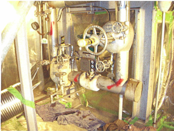
写真 4.4 水練り保温材使用の弁
