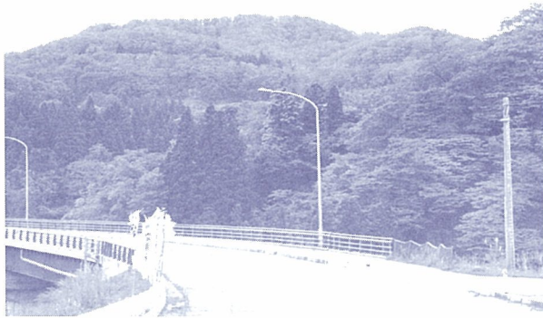
滝の沢地区へ向かう新しくできた橋
