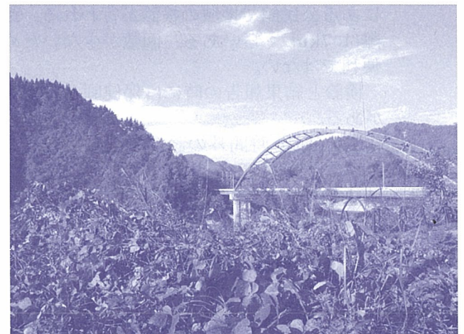
中津川地区を流れる白川にかかる橋
