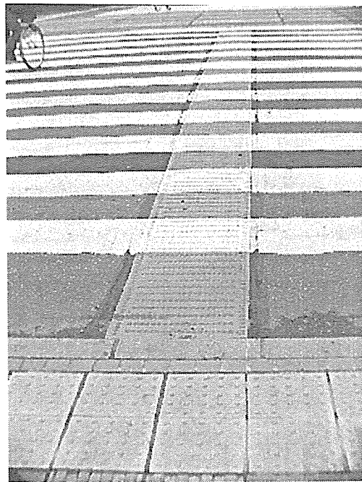
図12 エスコートゾーン（くまもと安心移動ナビプロジェクト） 60cmの幅があるので外れにくい。ゾーン上にいる間、「ポーン、ポーン」という 断続音が聞こえる
