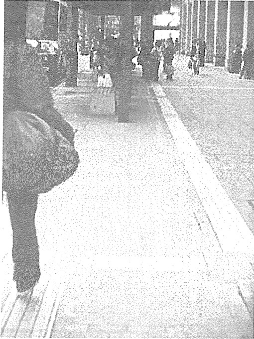
図15 クランク状に曲げられた点字ブロック（くまもと安心移動ナビプロジェクト） 進路上にバス停があるためにクランク状に曲げられている。「分岐点です。右に曲がります」と指示が出て、1mほど歩くと「分岐点です。左に曲がります」と誘導される
