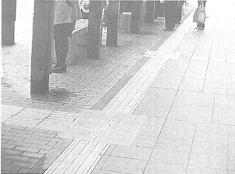
図16 頻繁に現れる分岐点（くまもと安心移動ナビプロジェクト） 分岐点に達してから必ずアナウンスが流れる。目的地とは全く関係のない情報の場合、いちいち立ち止まることは煩わしく感じる。
