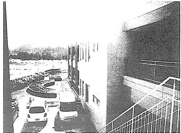
写真 増築部分の外観 増築部分の外観。写真中央のベランダが切れ ている部分が浴室と共同生活室。配管の取り 回しが難しい浴室は外部に面した部分に作る。
