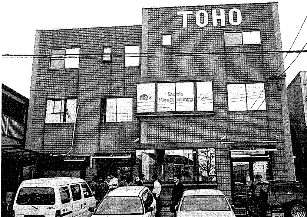
写真2：ブラジル人学校の裏側（貸しビルを1棟そのまま教室として利用している。画面右にも別棟の教室がある。）
